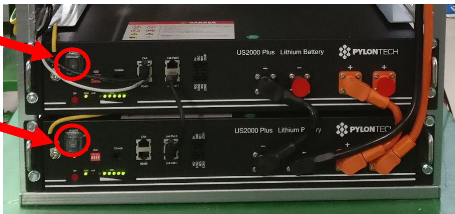
Figura 71 - Interruttori "0/1" moduli batteria: settare ad "1"
