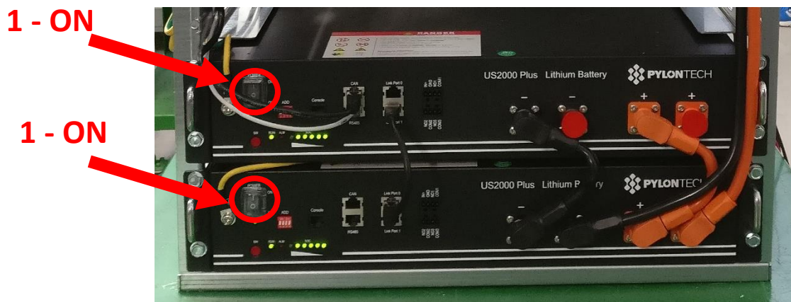
Figura 12 - Interruttori "0/1" moduli batteria: settare ad "1"
