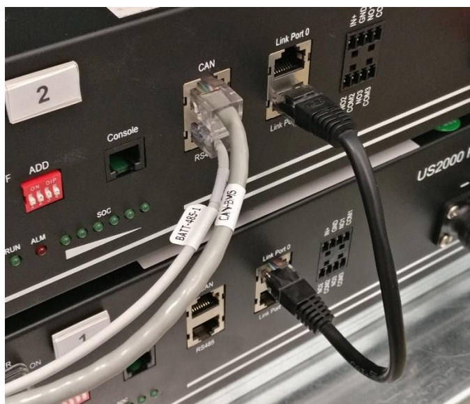
Figura 67 - Ripristino dei collegamenti: cavi segnali dati
