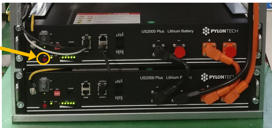
Figura 69 - Premere il pulsante rosso "SW" della batteria più in alto
