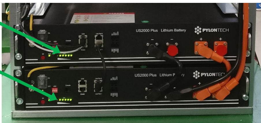
Figura 14 - Verificare accensione led moduli batteria
