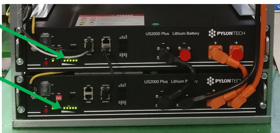
Figura 73 - Verificare accensione led moduli batteria
